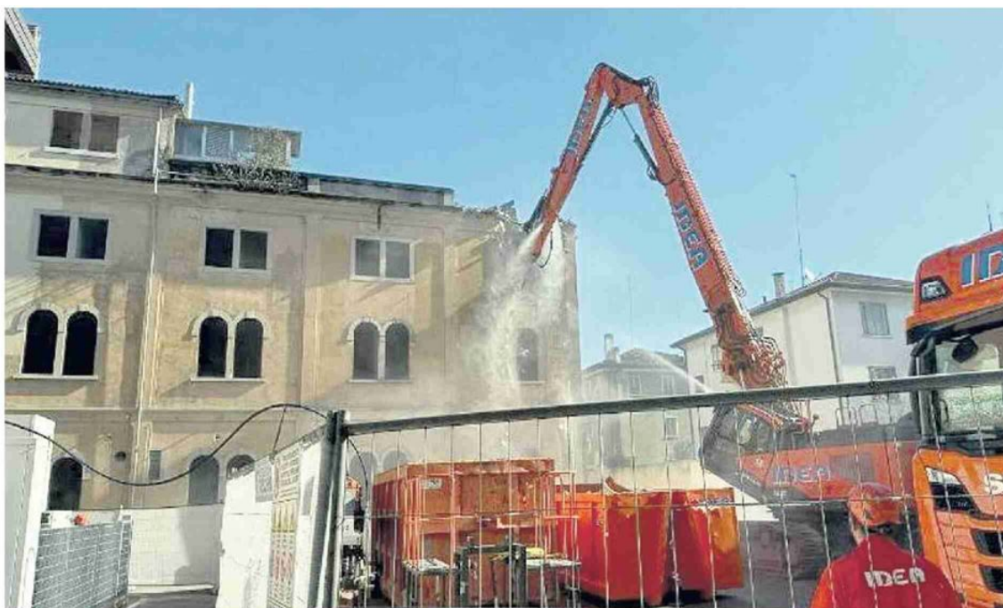
CASA DELLA COMUNITÀ I lavori di demolizione degli immobili che faranno spazio alla Casa della comunità di via Cappuccina
